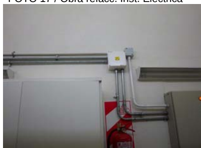
FOTO 17 / Obra refacc. Inst. Eléctrica
