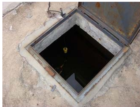
FOTO 44 / Tapa de inspección del Tanque de agua en azotea.
