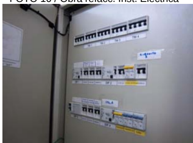
FOTO 16 / Obra refacc. Inst. Eléctrica
