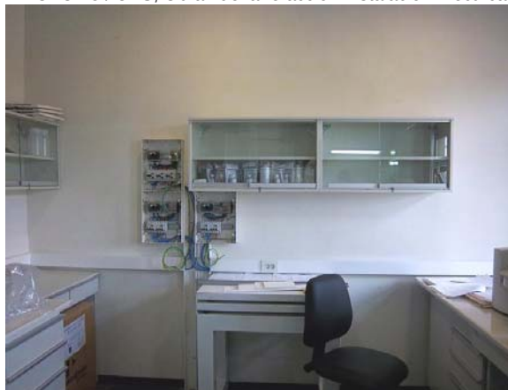
FOTO 15 / UPS, Obra nueva refacción Instalación Eléctrica
