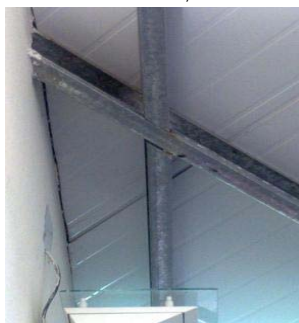
FOTO 36 /Cruce de correas, cielorraso.
