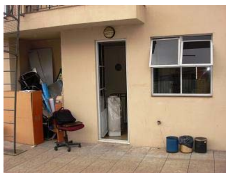
FOTO 50 / Puerta acceso a azotea. 143
