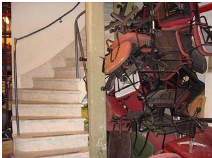
FOTO 10 / Llegada al Subsuelo. 136
