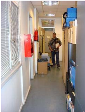
FOTO 41/ Pasillo obstruido. (b)
